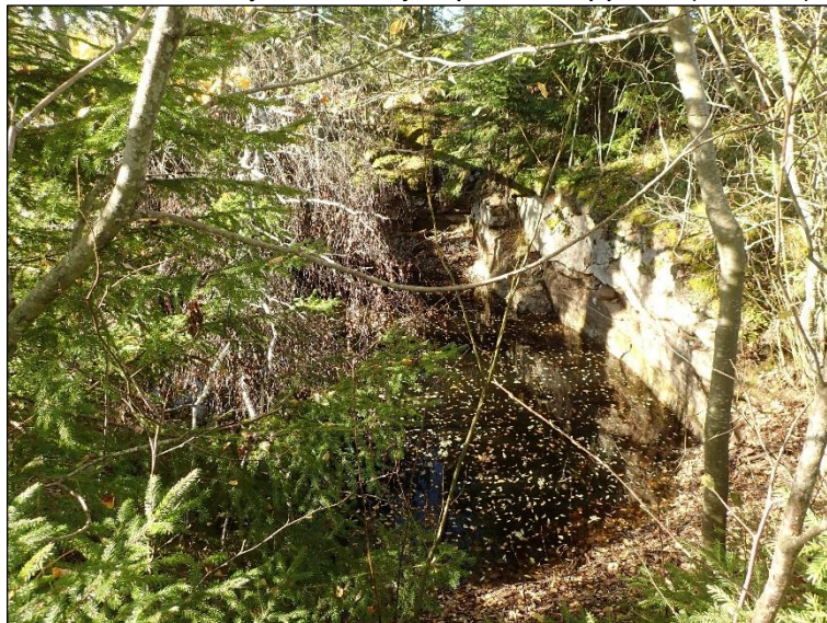
Kuopan (B3) seinämät ovat huolellisemmin suoriksi louhitut kuin mitä taisteluhautojen
