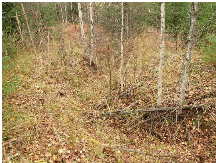
Maahan kaivettu ja varsin sortunut osuus notkelmassa (E4)
